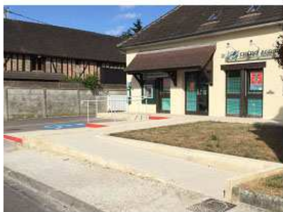
Une rampe d'accès pour personne en fauteuil roulant
