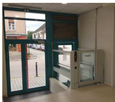
Un ascenseur pour accès à l'étage et / ou à l'agence
