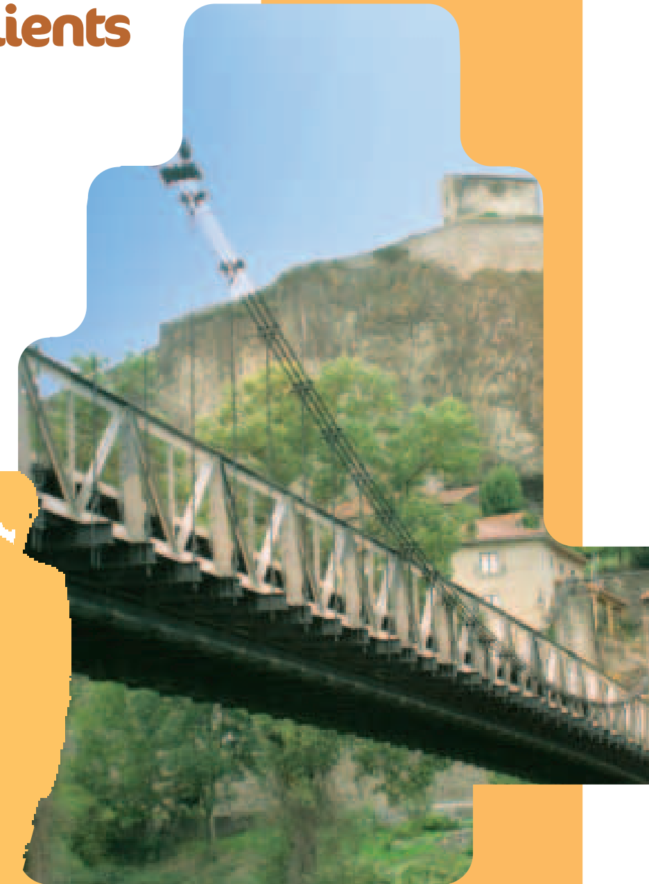
Pont de Chilhac
