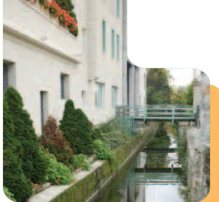
Passerelle à Brives
